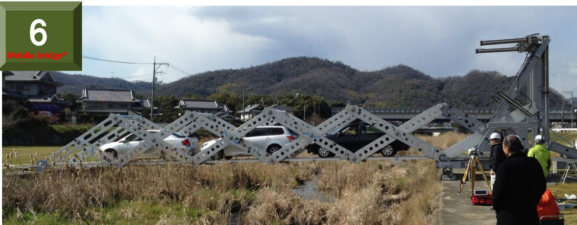
車両3台载荷による耐荷安全性の確認（運用は車1台/橋）本郷川にて。
